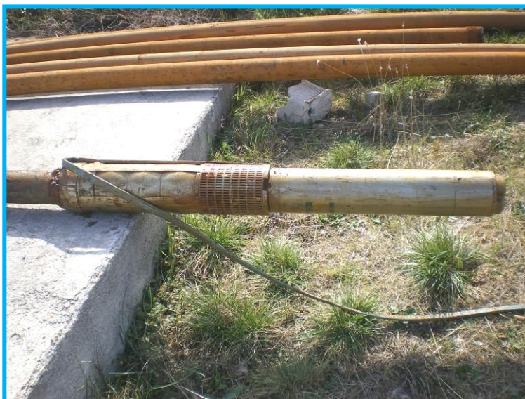
Ci-dessous : Remplacement pompe d'exhaure St Hilaire de Beauvoir Peillou
